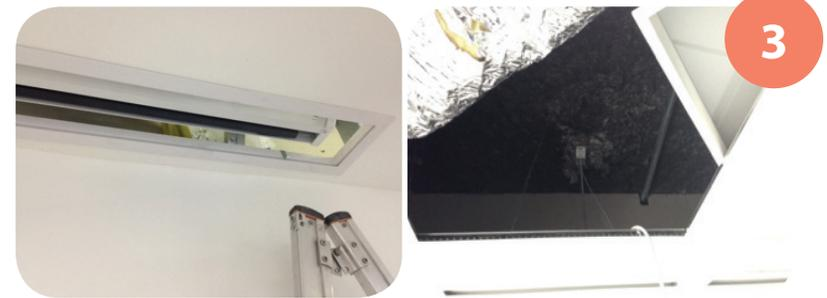
Com a fixação da moldura de acabamento, pudemos então colocar a tela de projeção, que ficou apoiada nela, mas com fixação própria para reforço
