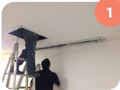
Como o forro era de gesso, para que não abrissemos mais um alçapão, criando a necessidade de serviços de reparos, utilizamos como alçapão o encaixe para a luminária. Desta maneira, tivemos acesso à laje para a fixação da moldura de acabamento e da tela elétrica para projeção em local firme
